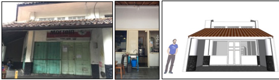
Gambar 8. Bukaan penuh dari lantai pada bangunan asli (kiri); perubahan menjadi bukaan sebagain pada objek studi (kanan) Sumber: Tim Peneliti, 2020
