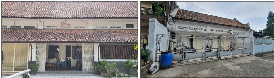
Gambar 3. Façade depan (kiri) dan Façade belakang (kanan) bangunan Antico Coffee Sumber: Tim Peneliti (2020)
