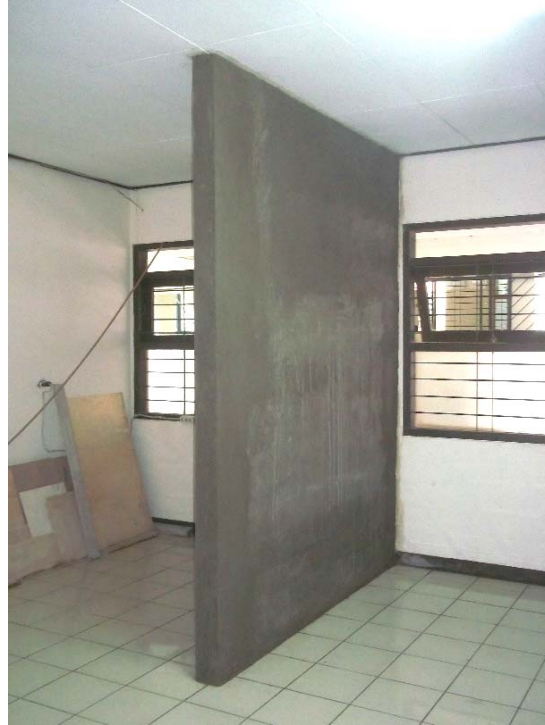
Gambar 5 Dinding Mortar Cor Ditempat Ukuran Sebenarnya
