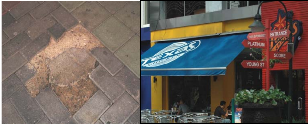
Gambar 9 Kerusakan Paving Block. Gambar 10 Papan Penunjuk Arah.
